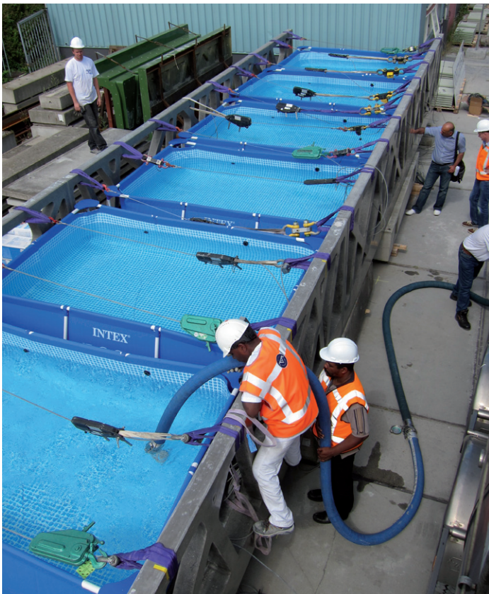
Proefbelasting op dek, met water gevulde bakken, tot minimaal 6kN/m 2
