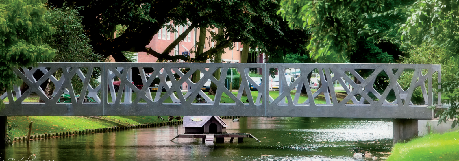
Modulaire fiets- en voetgangersbrug te Rotterdam in UHSB
