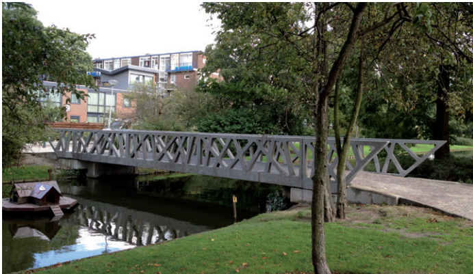
Modulaire fiets- en voetgangersbrug in UHSB tijdens de bouwfase
